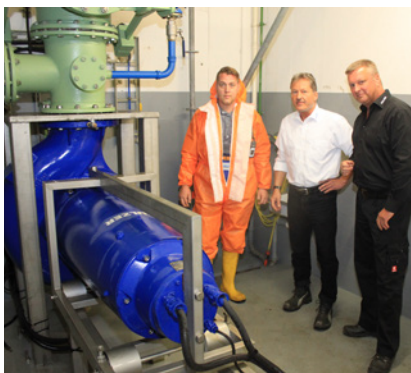
Sulzer Abwasserpumpe Baureihe XFP mit Wartungsschlitten
