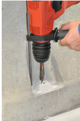
Afb. 5b Bevestigingsgaten boren
