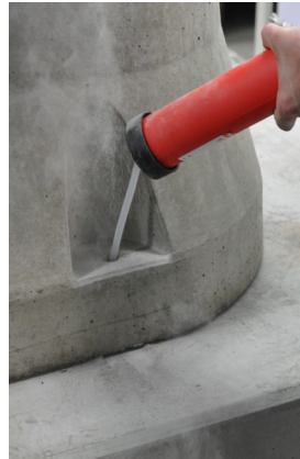
Afb. 5c Boring uitblazen
