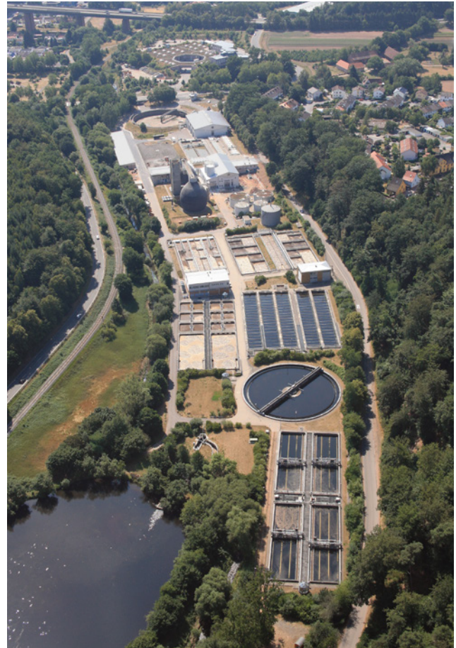
The sewage treatment plant of Stadtentwässerung Kaiserslautern
