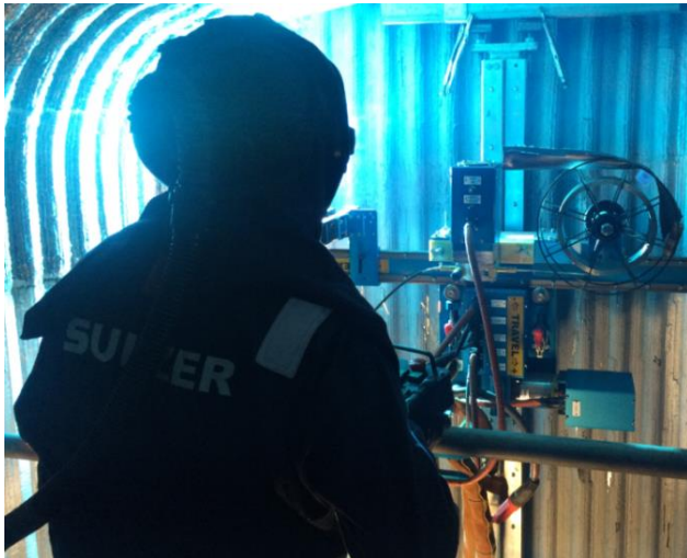
Bild 1: Automatisiertes Auftragschweißen
