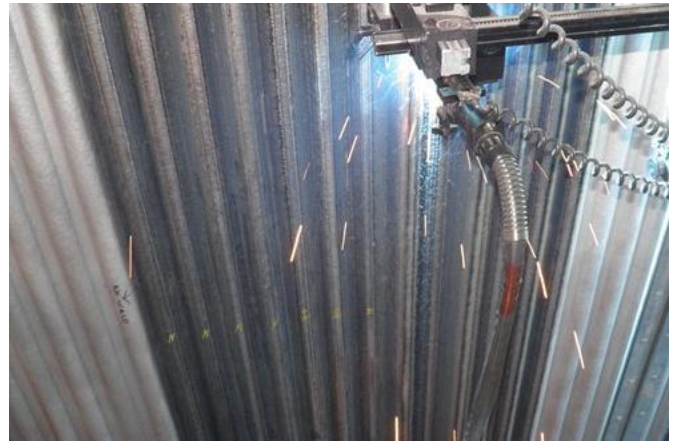
Bild 2: Auftragschweißen vor Ort
