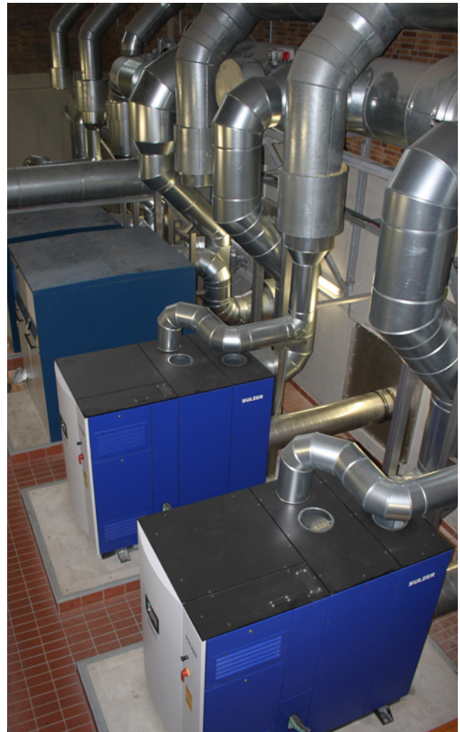
Die neuen Sulzer HST 20 Turboverdichter
