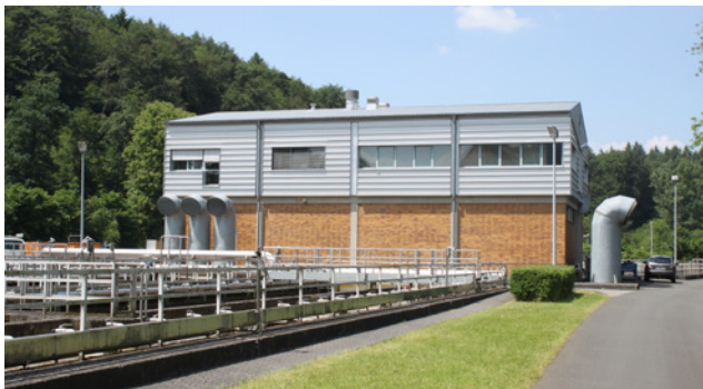
Maschinenhaus hinter den Becken, rechts die Ansaugstutzen für die Belüftung
