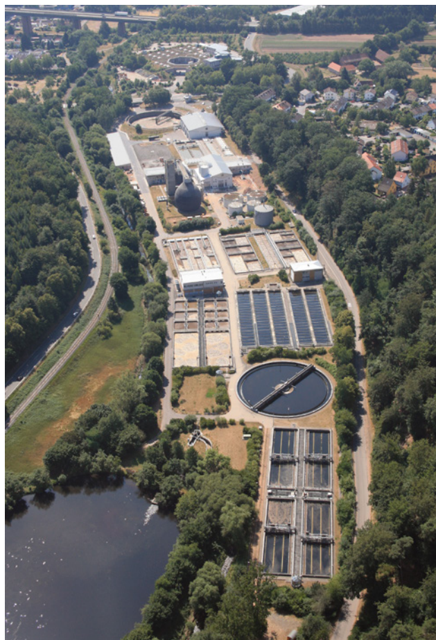
Die Kläranlage der Stadtentwässerung Kaiserslautern
