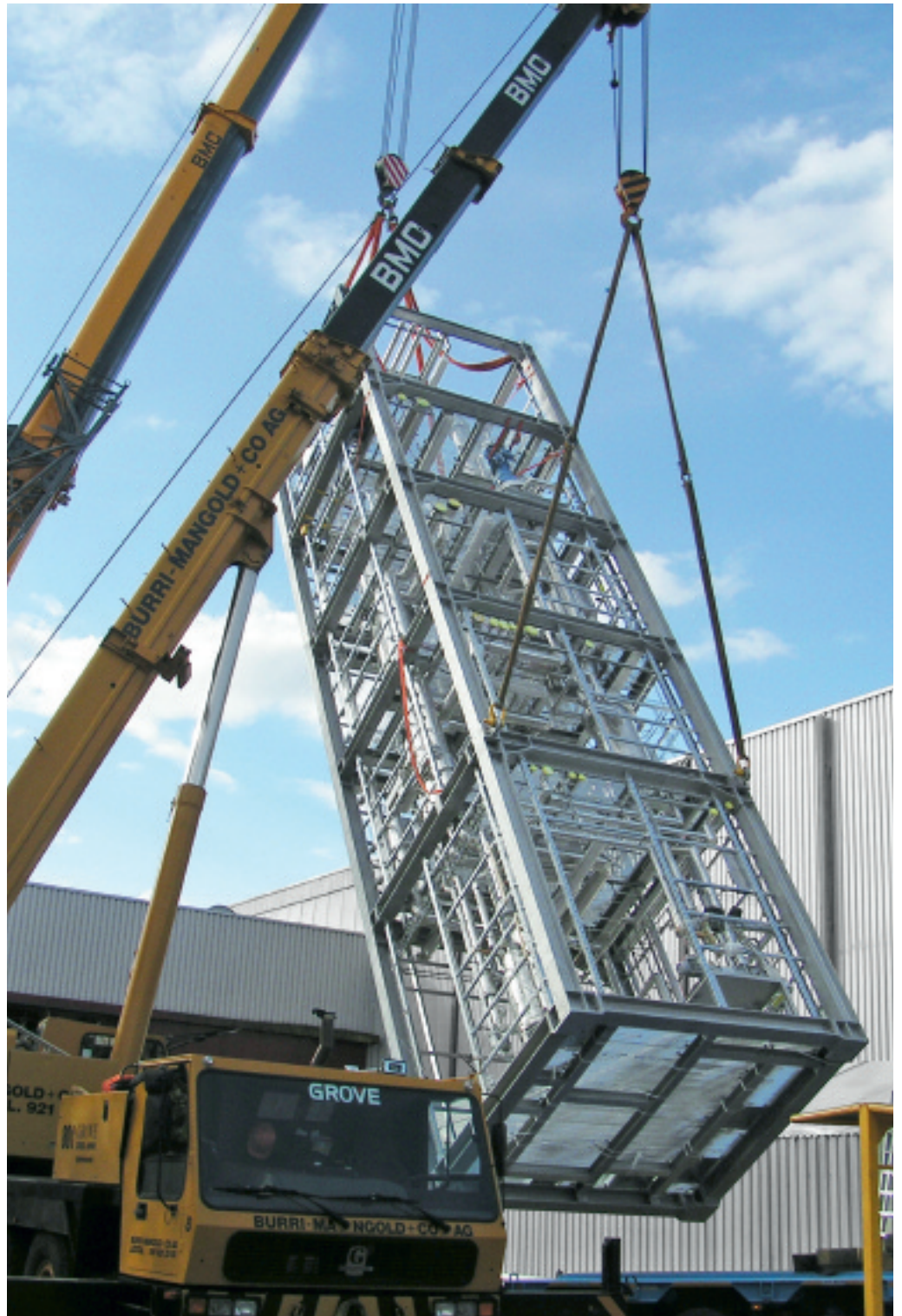
5 Verladen einer modularen Anlage von Sulzer Chemtech zur Lösungsmittelrückgewinnung und -reinigung.
