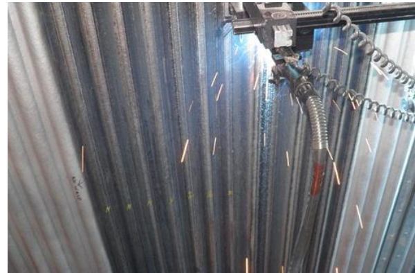
Figura 2: Soldagem de revestimento em andamento
