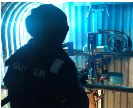
Figura 1: Soldagem de revestimento automática
